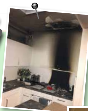
Die unschöne Bescherung kurz vor Weihnachten: Der Kochbereich ist total zerstört
